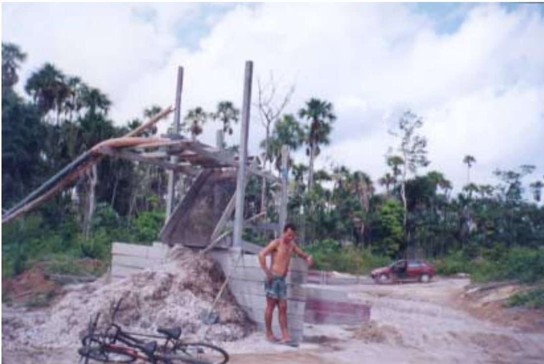
FOTO 16: Areia utilizada na construção civil.
