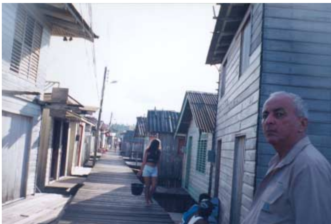
FOTO 05: Estivas e palafitas de madeira sobre o setor alagado da zona portuária na Av. Beira Rio.
