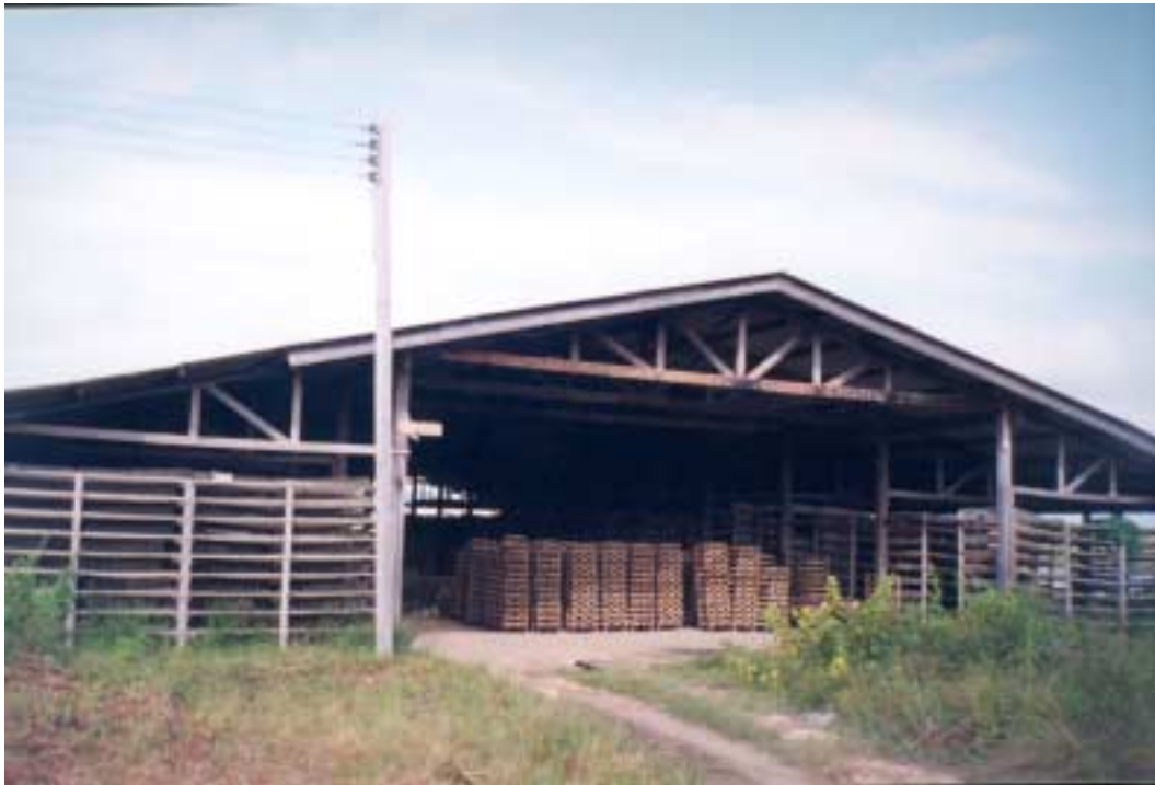
FOTO 14: Olaria Laranjal, galpão mostrando telhas e tijolos prontos para serem queimados.
