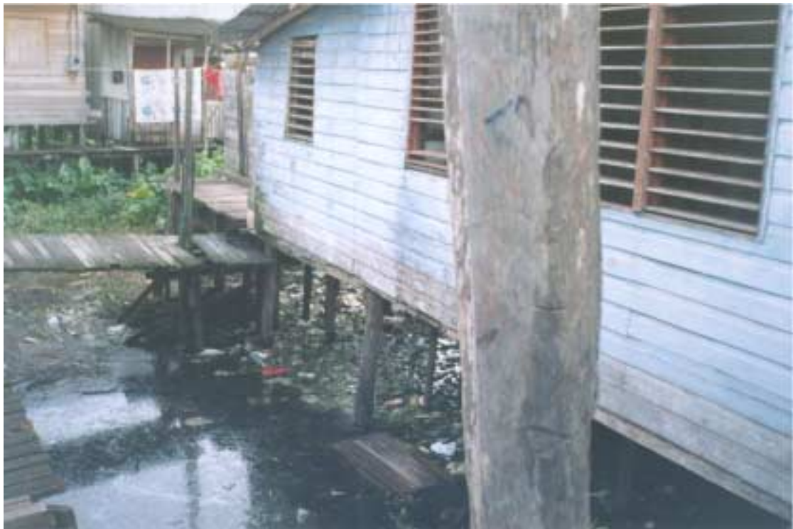
FOTO 08: Observa-se o lixo depositado na zona alagada sob as palafitas.
