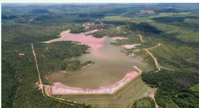
Barragem Aroeira, da Nexa, em Vazante (MG)
