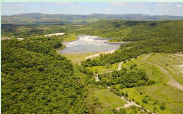
Barragem Turmalina, em Conceição do Pará (MG)
