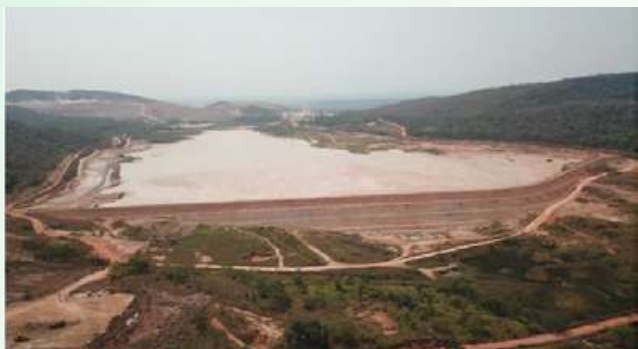
Barragem EPP, da Apoena, em Pontes e Lacerda (MT)
