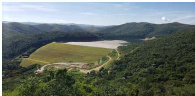
Barragem Cuiabá, em Sabará (MG)
