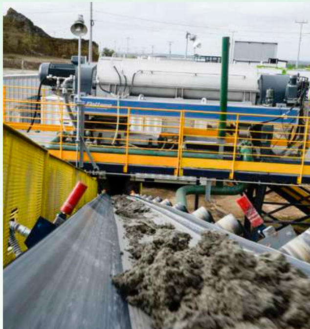
Sistema de recuperação de água na Mina Braúna
