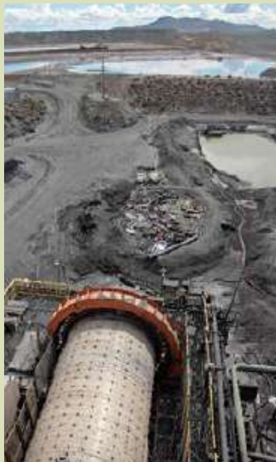
Instalação do novo moinho de bolas na mina Maracás Menchen
