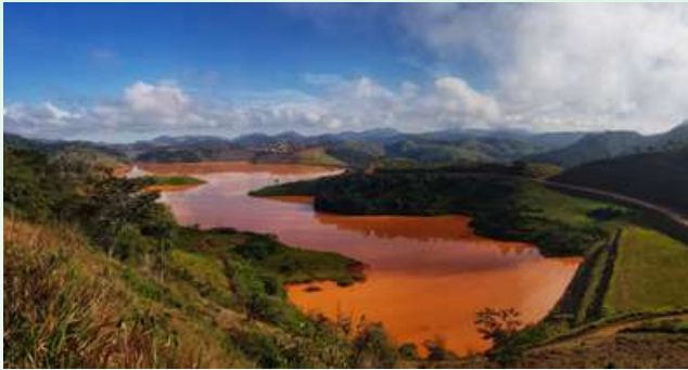
Barragem da CBA, em Mirai (MG)
