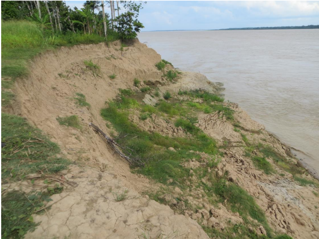
Figura 11: margem do rio Solimões, vila do Cuia- Anamã - AM, local de ruptura rotacional formando enseadas.
