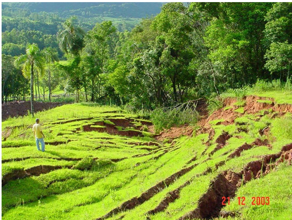
Figura 8: Rastejo evoluindo para rupturas rotacionais, Vale do Sol-RS. Bressani, 2013
