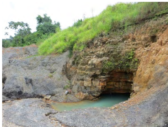
Abertura de mina abandonada com geração de drenagem ácida, em encosta coberta por rejeitos da mineração do carvão.
